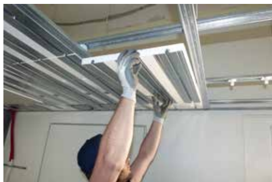
6. Pose de la plaque RAUTOP
