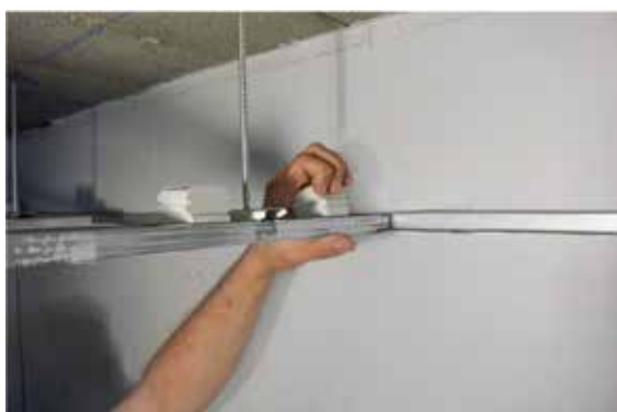
3. Pose des blocs de fixation sur le rail
