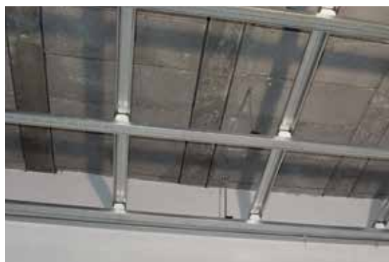
4. Pose des renforts perpendiculairement aux rails
