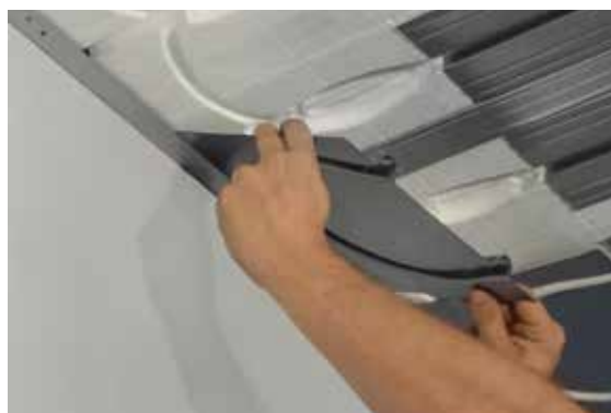
8. Pose du diffuseur virage métallique
