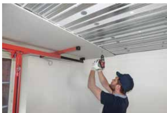
10. Pose du parement final
