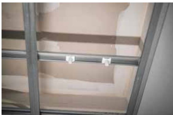
5. Pose des crochets de fixation pour maintien des dalles RAUTOP
