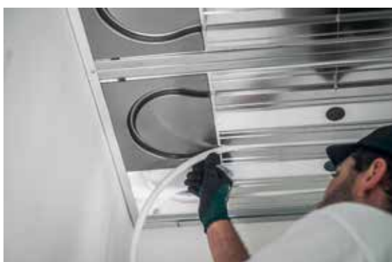
9. Pose du tube RAUTHERM silence dans les rainures préformées
