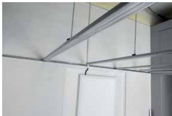
2. Pose de l'ossature primaire
