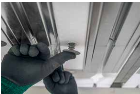
7. Fixation de la dalle RAUTOP à l'aide des sapins de fixation
