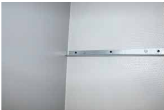
1. Pose de la cornière périphérique
