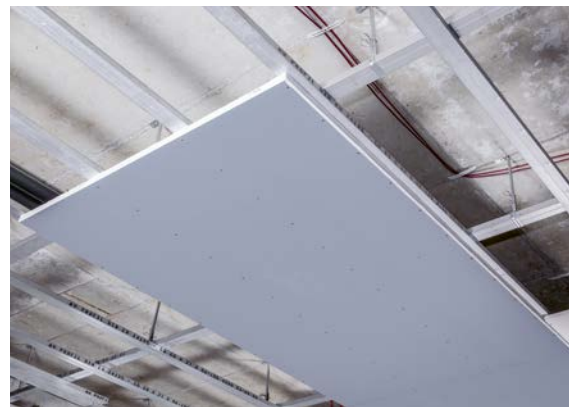
Abb. 04-11 Montiertes Deckenelement
