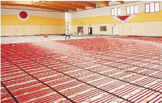
Abb. 07-14 Schwingbodenheizung mit Industrieverteiler
