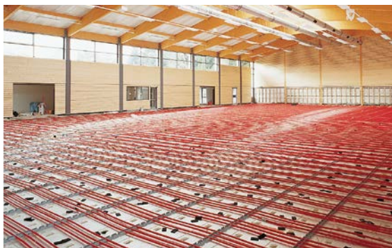
Abb. 07-22 SBH System Rohrverteiler
