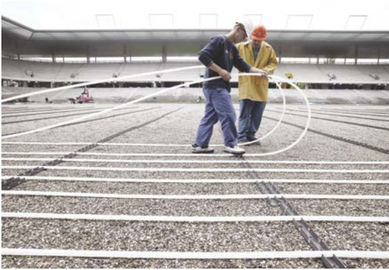
Abb. 09-2 Heizungsrohre verlegen
