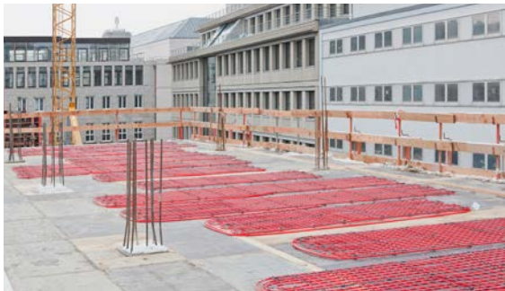
Abb. 05-11 Positionierte oBKT-Module
