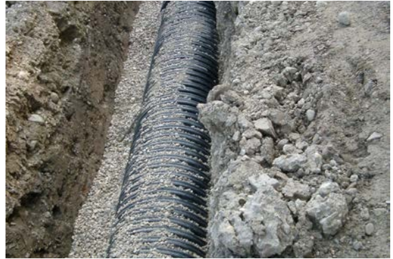
Afb. 07-3 RAUPIPEX-buis in sleuf
