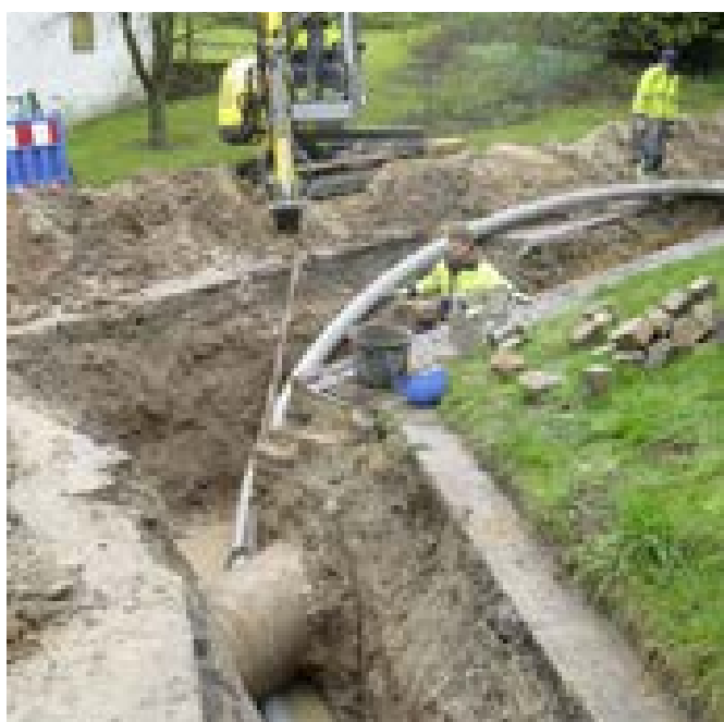
Obr. 7-22 Jednoduchá pokládka pomocí ohebného vedení potrubí
