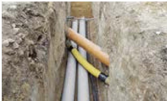
Obr. 7-20 Zkřížení křížujících se potrubí
