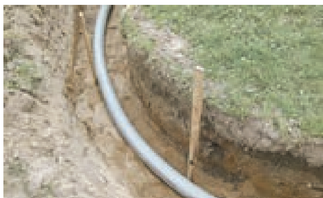
Obr. 7-21 Změna směru bez použití tvarovky
