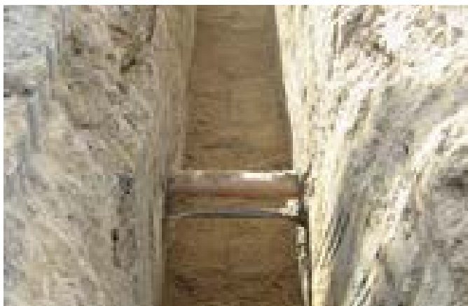
Obr. 7-2 Pata výkopu s trubní podpěrou
