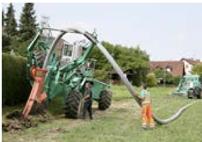
Obr. 7-8 Pokládka potrubí s pluhem
