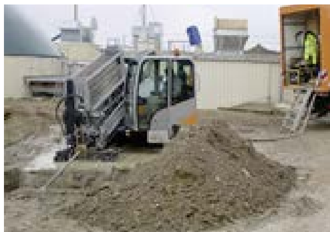
Obr. 7-10 Pokládka potrubí pomocí vyplachovacího vrtu
