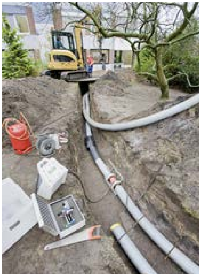
Obr. 4-11 FUSAPEX-svařování spojů v praxi
