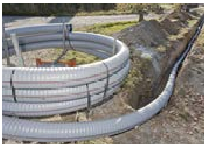
Obr. 7-30 Pevné horizontální odvíjecí zařízení na konci výkopu
