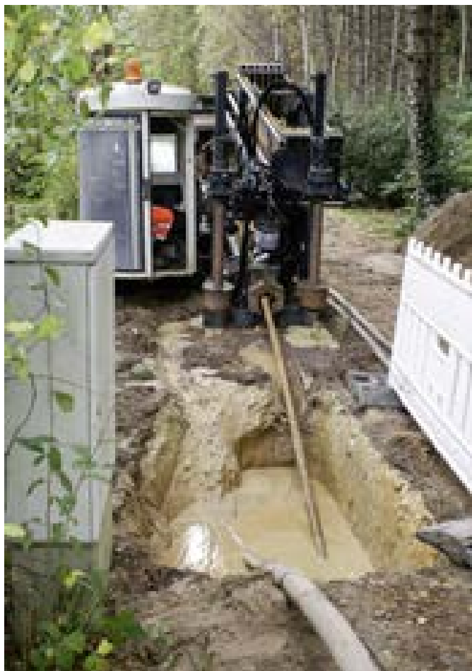
Obr. 7-13 Vrtání s vyplachováním RAUTHERMEX
