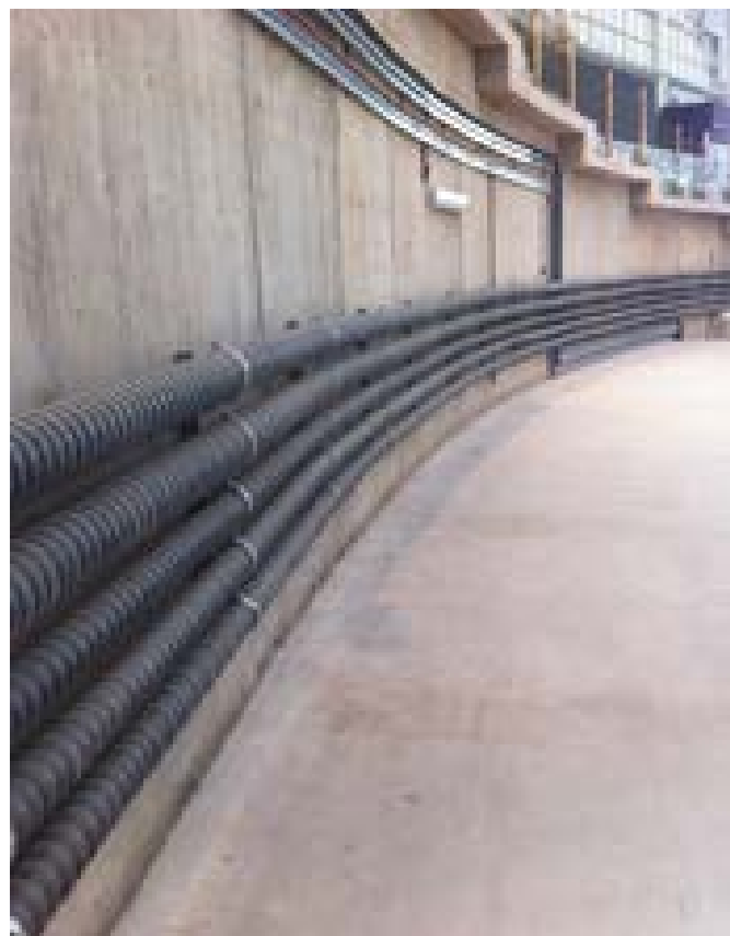
Obr. 7-26 Příklad volné pokládky/montáž na zeď
